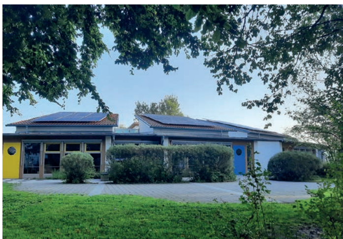
Die sechs Monate alte Solaranlage vom Kindergarten „Am Kraxelbaum“
